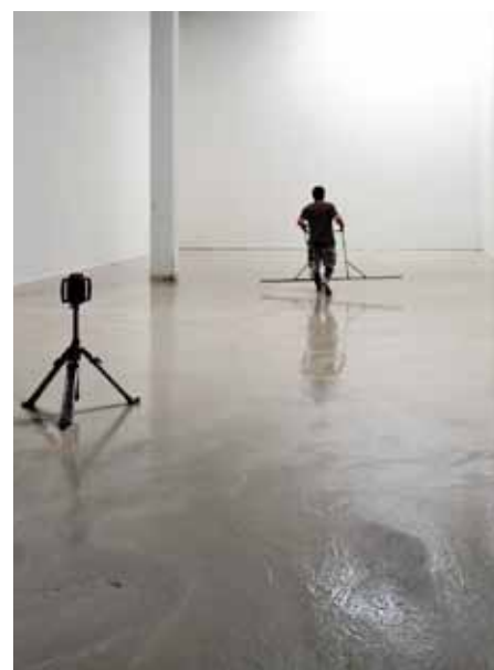
Anhyment – srovnání nivelační hrazdou
