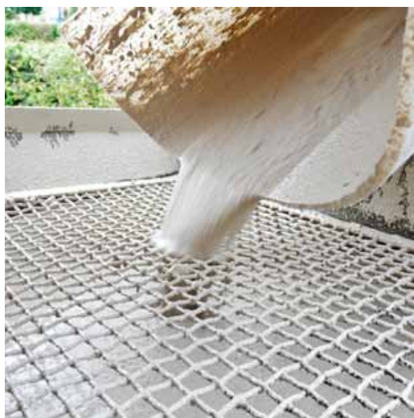
Anhyment – plnění šnekového čerpadla
