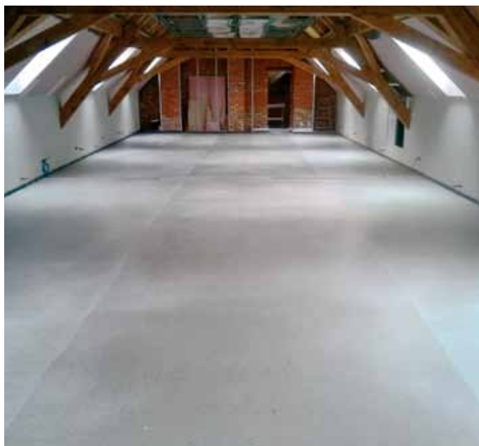
Cemflow – hotový potěr druhý den po uložení
