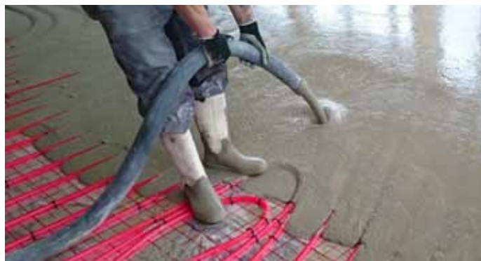
Ukládka samonivelačních litých potěrů
