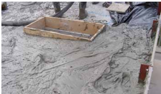
Provádění ploché střechy
