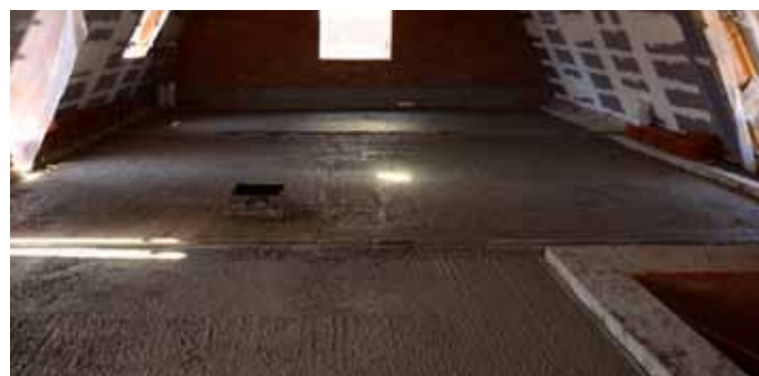
Vyrovnání podlahy podkrovní nad klenbovým stropem
