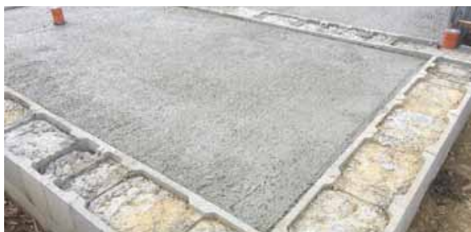
Vyplňování základů rodinného domu v Bubovicích
