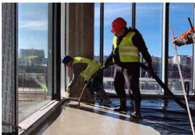
Ukládka Cemflow, administrativní budova Beethoven
