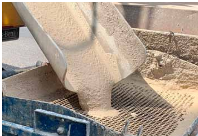
Směs Anhymentu tekoucí z koryta autodomíchávače do šnekového čerpadla
