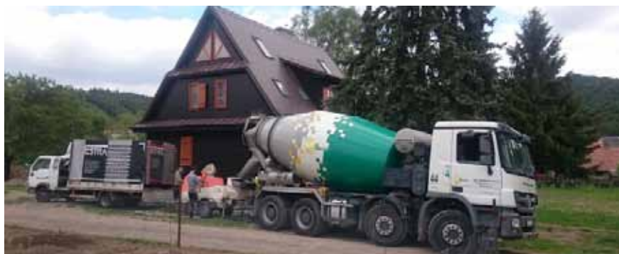
Plnění čerpadla z autodomíchávače
