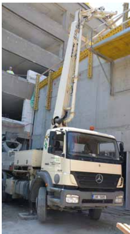
Průběh betonáže
