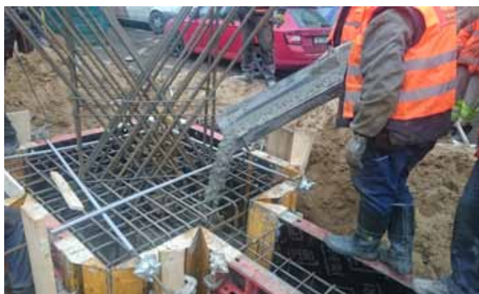
Průběh betonáže
