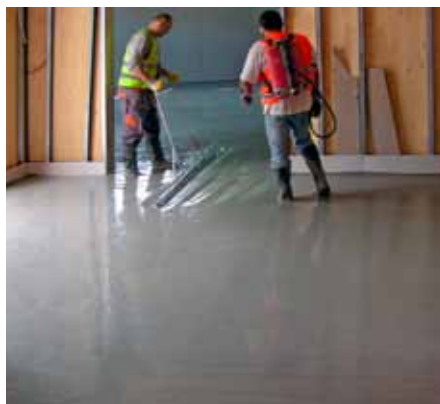
Obr. 2: Nivelace litého cementového potěru CemFlow
