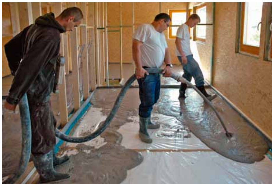
Obr. 5: Lití potěru CemFlow
