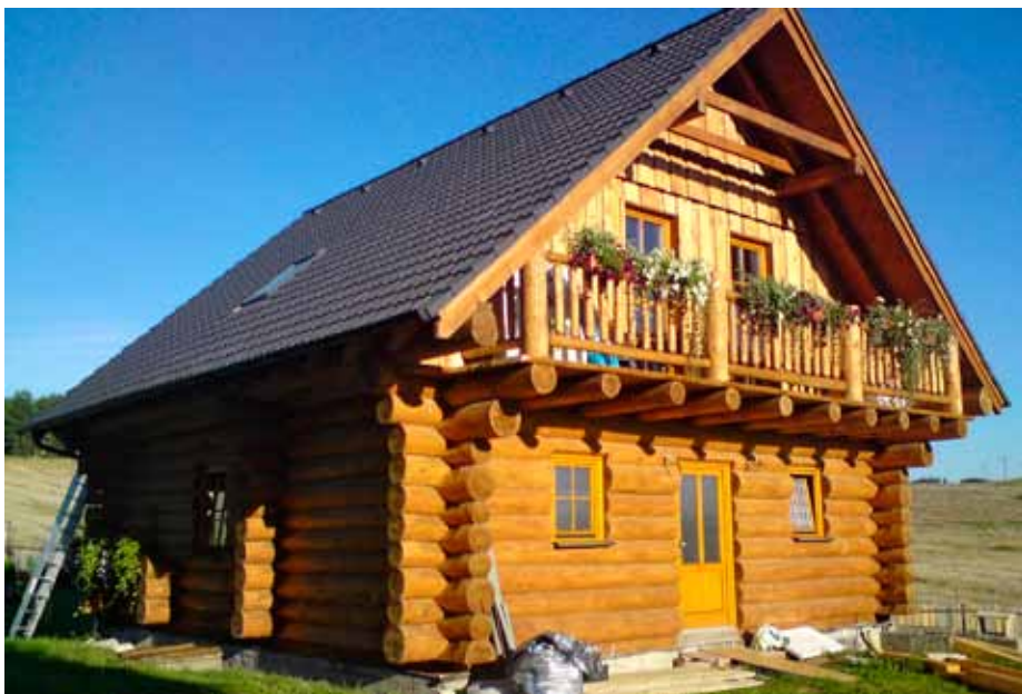
Obr. 3: Srub, kde byl CemFlow použit
