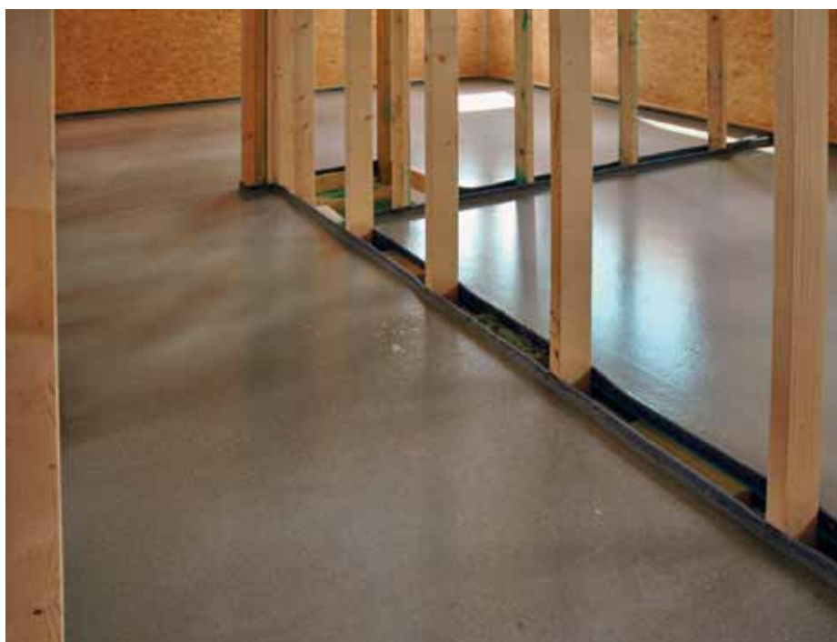
Obr. 6: Vzhled uloženého a ošetřeného potěru CemFlow
