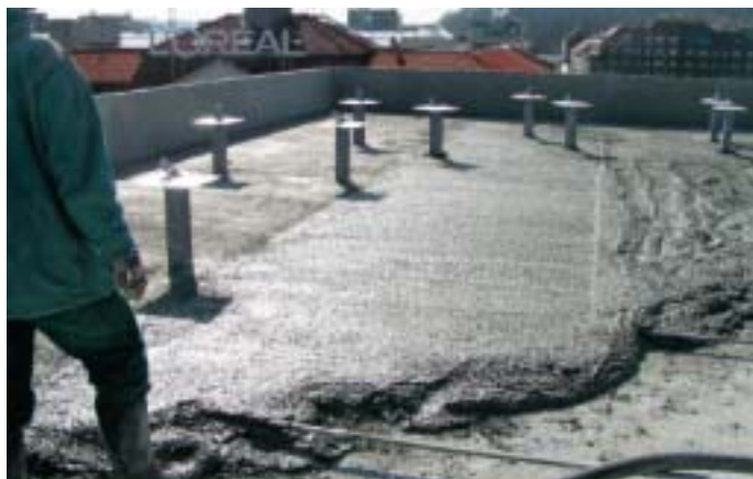
Obr. 5: Lití do spádu na střeše – Poriment PS
