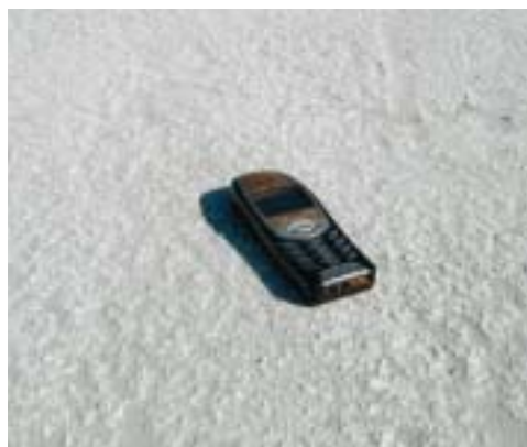
Obr. 2: Povrchová struktura Porimentu PS na střeše před pokládkou hydroizolace
