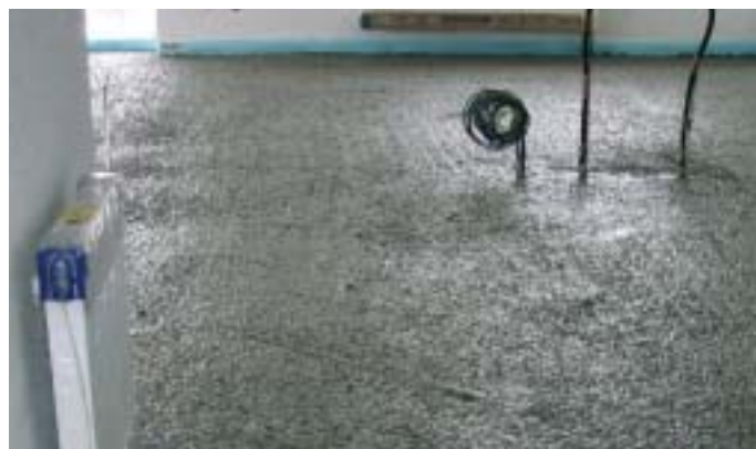
Obr. 4: Zalítí rozvodů, hrubá rovina – ideální podmínky pro položení kročejové izolace
