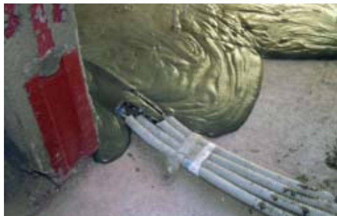
Obr. 3: Zalítí rozvodů – Poriment W
