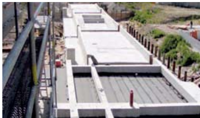
Obr. 2: Spádové vrstvy, Poriment PS – 500, podzemní cesta River City Prague, Praha 8
