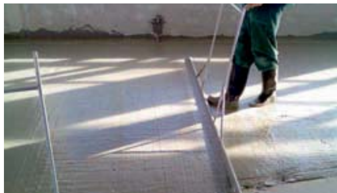
Obr. 1: Tenkovrstvé vyrovnání pod desky polystyrénu, Poriment W – 600, rekonstrukce ČKD Kolbenova, Praha 9
