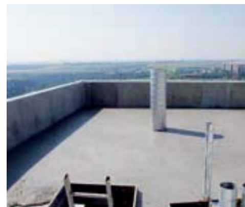
Obr. 7: Spádová vrstva, dopravní výška 80 m, Poriment PS – 500, BD Petržilkova, Praha 13
