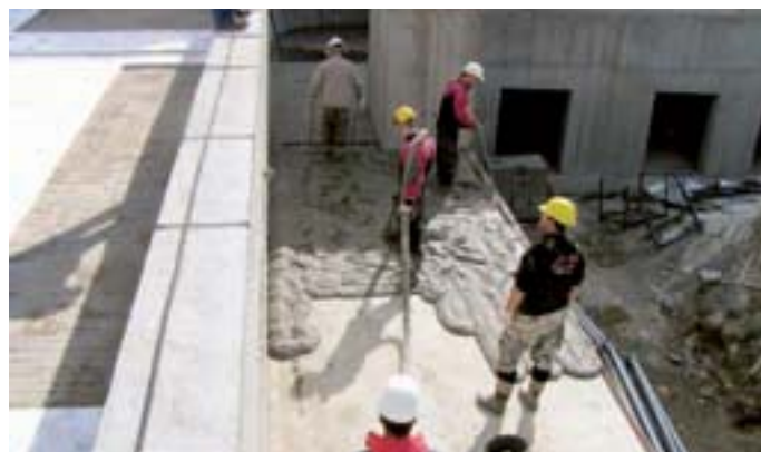
Obr. 3: Lití Porimentu PS – 500
