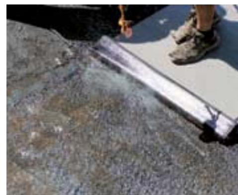
Obr. 5: Natavování hydroizolace
