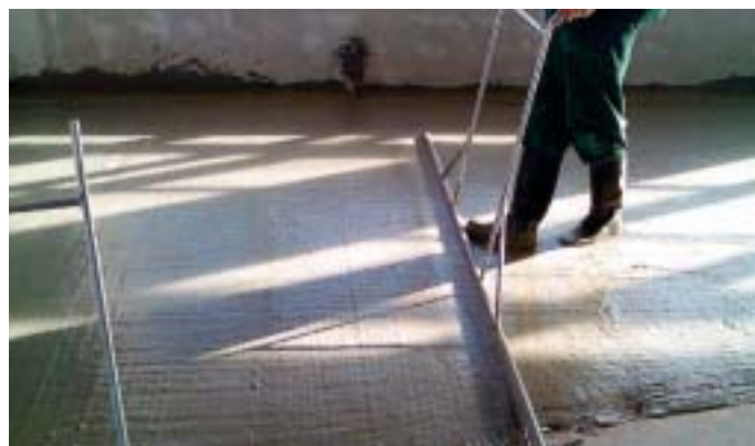
Poriment W – 600, tenkovrstvé vyrovnání podkladu
