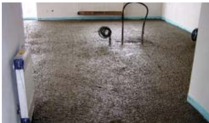
Poriment P – 300, zalité rozvody, rovný podklad – ideální pro pokládku kročejové izolace
