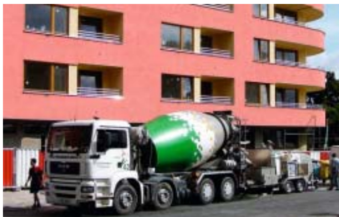
Skládání do čerpadla, bez elektřiny, bez vody (BD Bartoškova, Praha 3)
