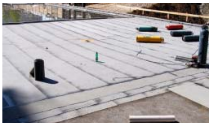
Poriment PS – 500, natavená hydroizolace, v pozadí zátopová zkouška
