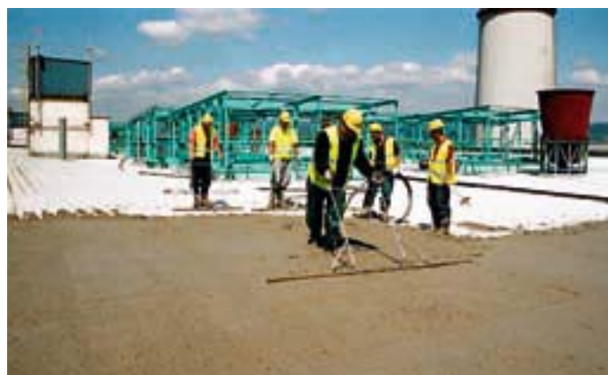
PORIMENT PS-600 na ploché střeše elektrárny Tušimice o spádu 8 %
