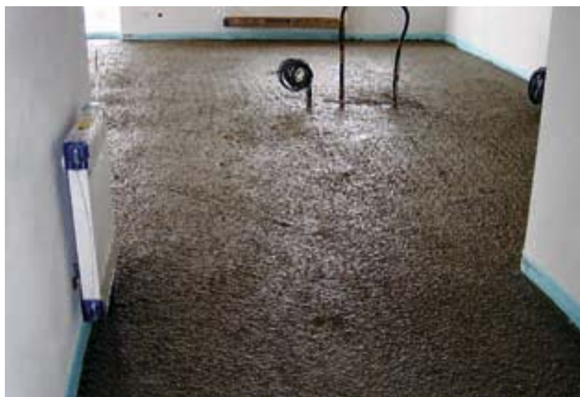
Poriment P, podlaha, bytová výstavba
