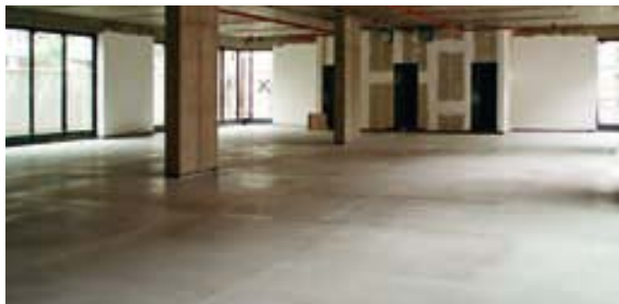
Přesná rovinatost povrchu CemFlow – hala
