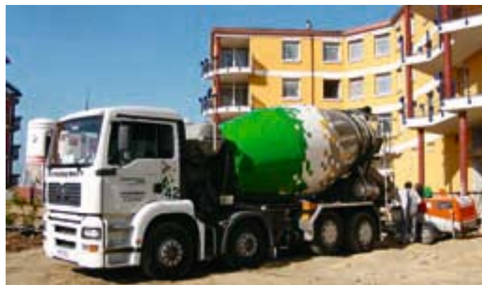
Doprava autodomíchávači, čerpání dieselovými čerpadly
