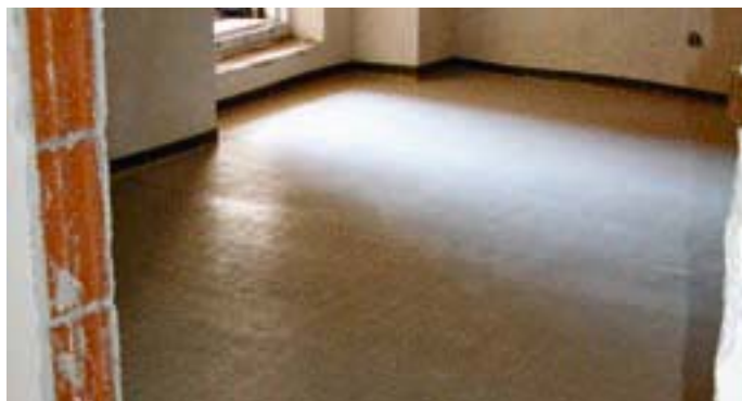
Hotový litý cementový potěr CemFlow – byt
