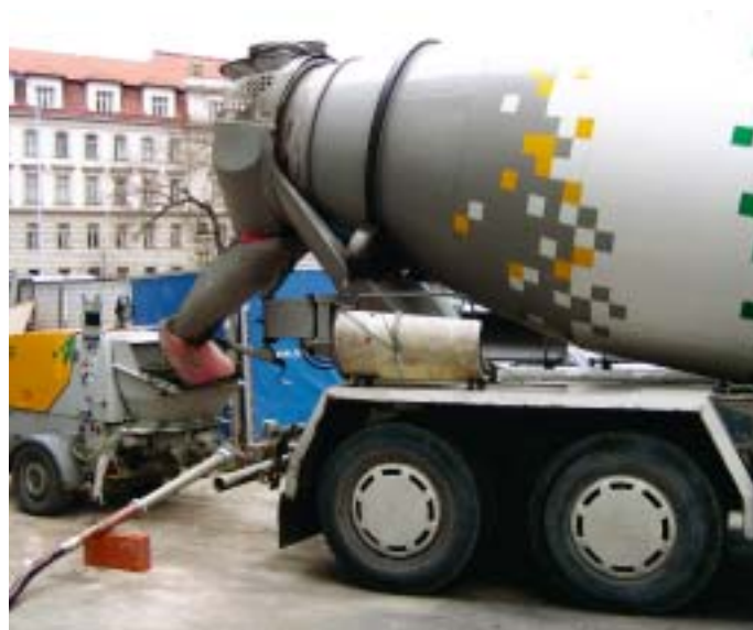
Obr. 3: Čerpání pístovým čerpadlem
