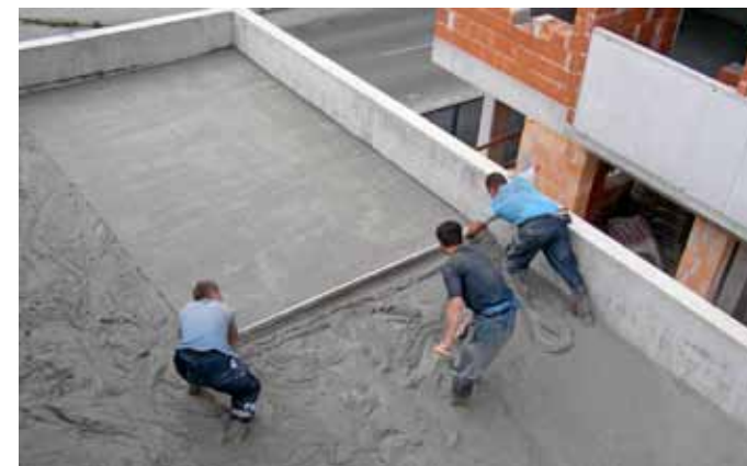
Obr. 5: Poriment WS – 700, spádová vrstva ploché střechy
