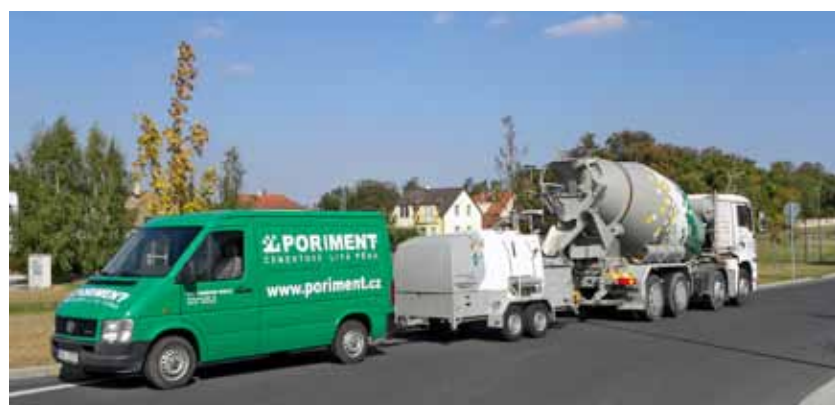
Obr. 3: Doprava autodomíchávačem, čerpání dieselovým čerpadlem
