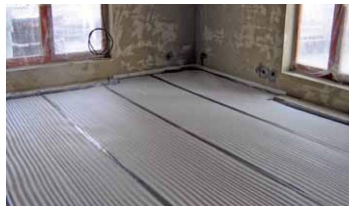
Obr. 2: Celoplošně položená kročejová izolace (podklad Poriment)
