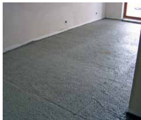
Obr. 1: Poriment P – 300, zalité rozvody, připraveno pro položení kročejové izolace
