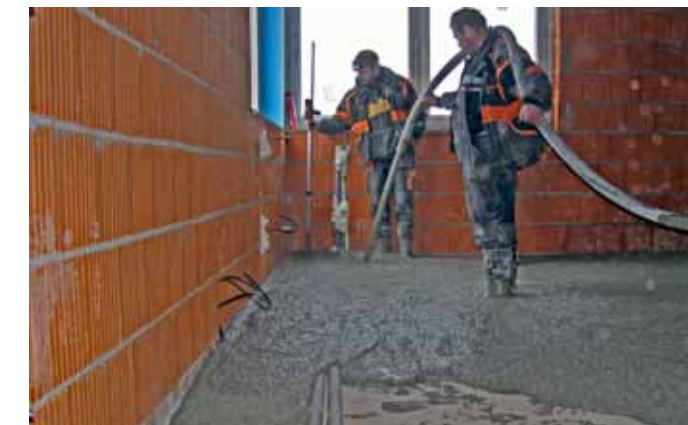
Obr. 6: Poriment P – 300, lití čerstvé směsi
