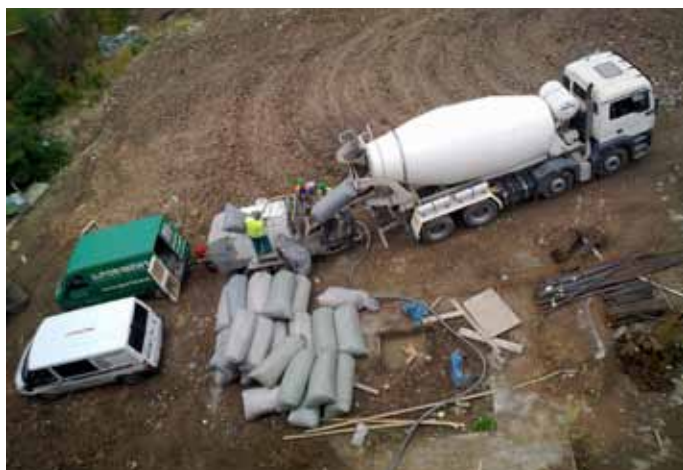
Obr. 1: Výroba Porimentu® PS 500 na stavbě
