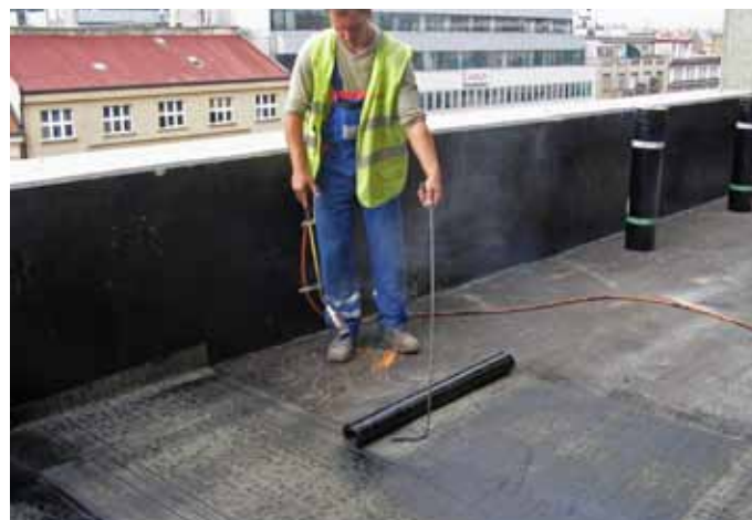
Obr. 6: Natavování izolace
