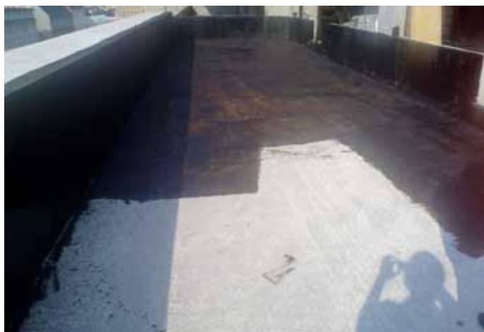
Obr. 5: Provádění penetrace na Poriment®
