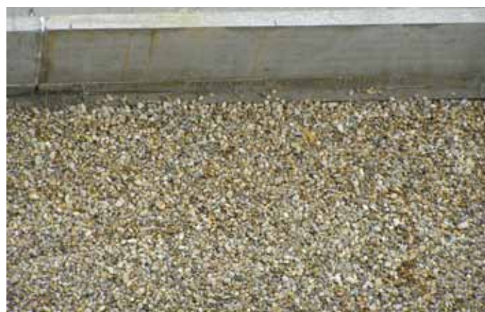
Obr. 8: Zatížení izolace kačirkem
