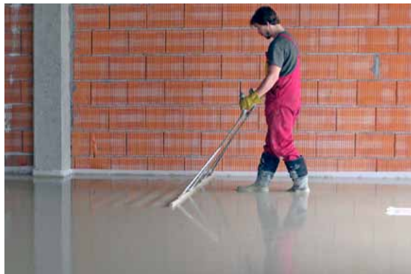
Zpracování podlahového potěru tzv. ráklováním
