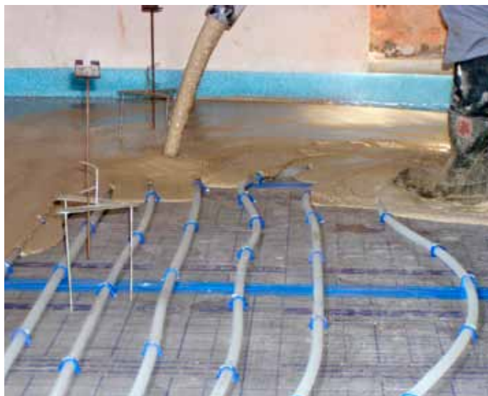
Lití podlahového potěru na podlahové vytápění
