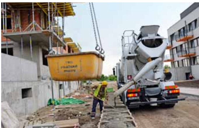
Skládání čerstvé malty z autodomíchávače do plastových kontejnerů
